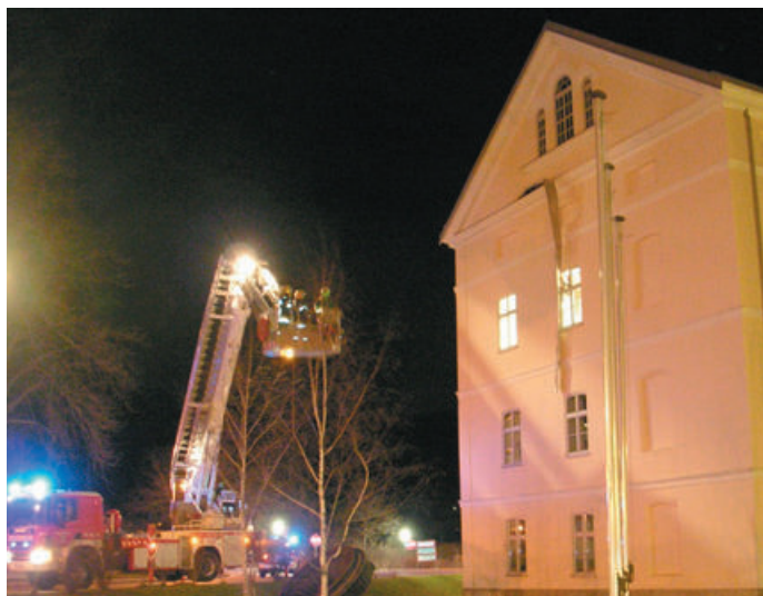
Sturmschaden an der Hauptschule.
