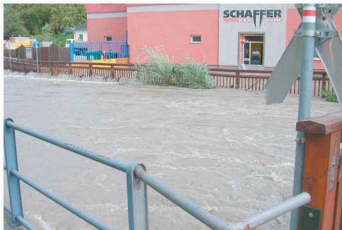
Durch wirksamen Hochwasserschutz konnte größerer Schaden verhindert werden.
