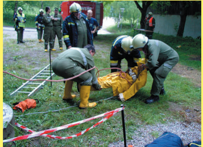
Ein Kanalarbeiter wurde im Schacht bewusstlos
