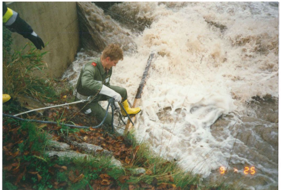
Foto: Hochwassereinsatz: Immer wieder müssen die Wehranlagen von Schwemmholz gereinigt werden.
