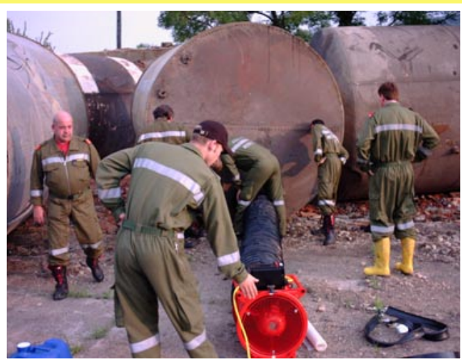
Die Terpentin-Tanks werden mit Leichtschaum gefüllt.
